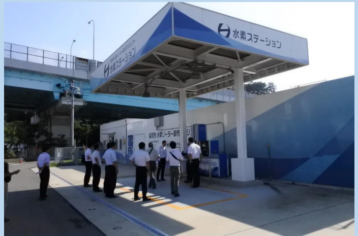
〔水素ステーション〕
